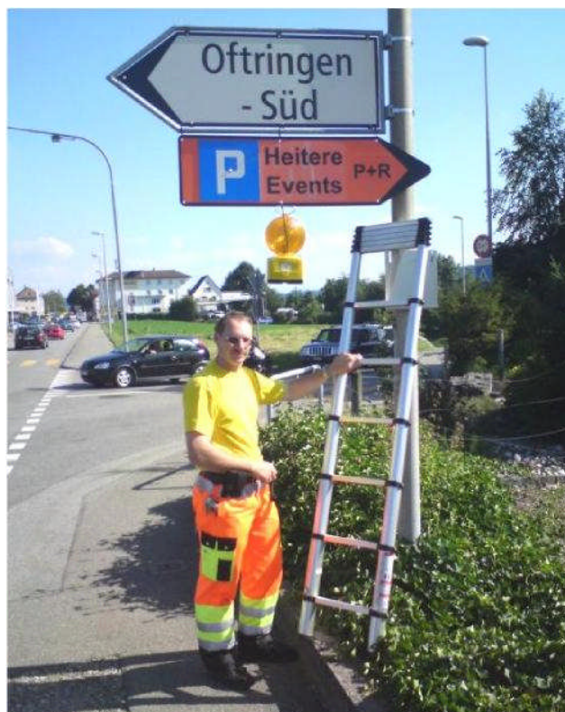
Erstellen der Zufahrts-Signalisation anlässlich des Heitere Open Air's in Zofingen
